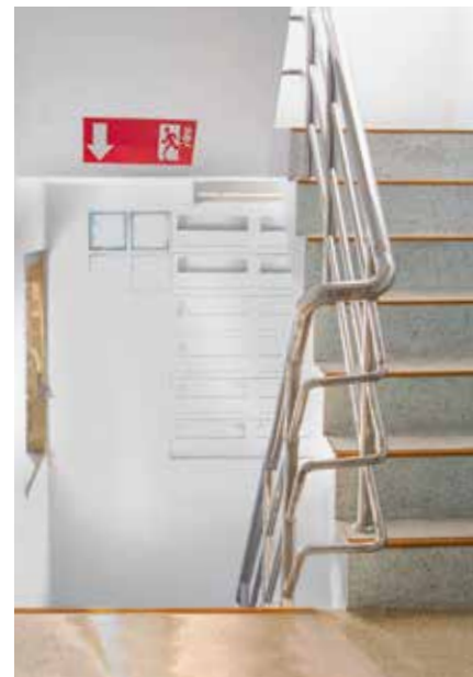
So soll ein Treppenhaus eigentlich aussehen.
